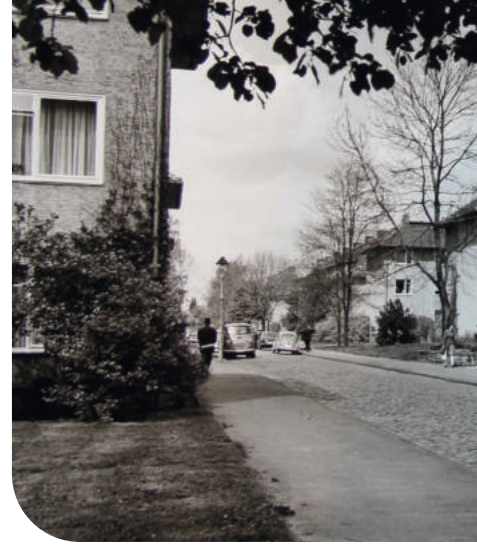
Fiedlerstraße - Fraunhoferstraße Wiederaufbau BJ. 1953
