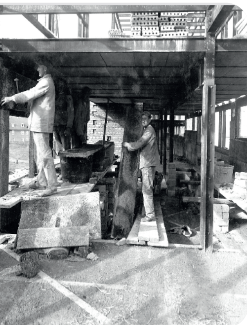
Bau der Rothenbergsiedlung 1930
